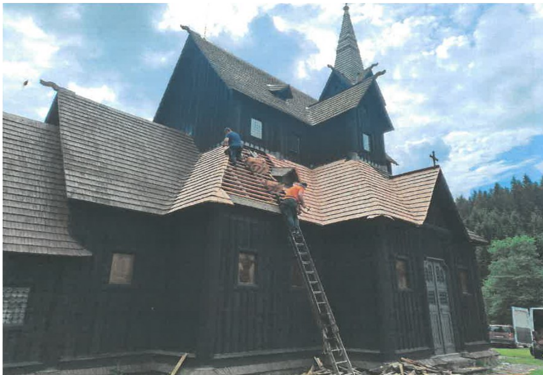
V průběhu obnovy
