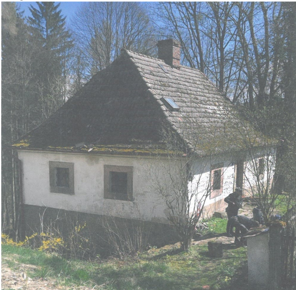
Stav před obnovou
