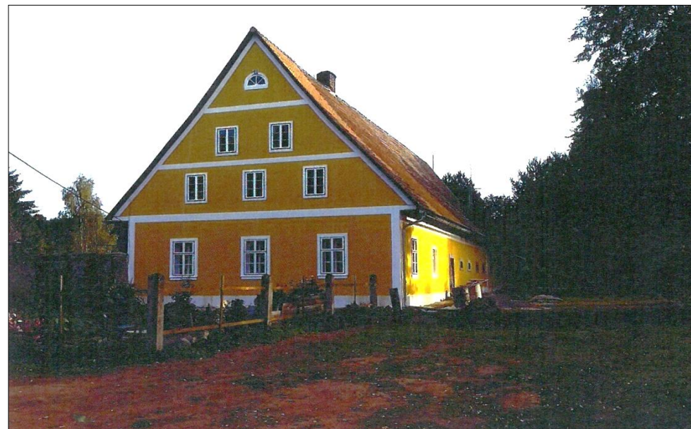
Stav objektu po obnově
