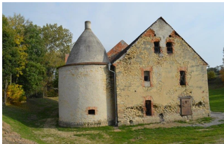
Stav památky před celkovou obnovou
